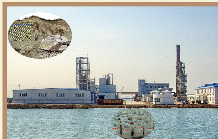
万吨级海水直接提钾试验厂
